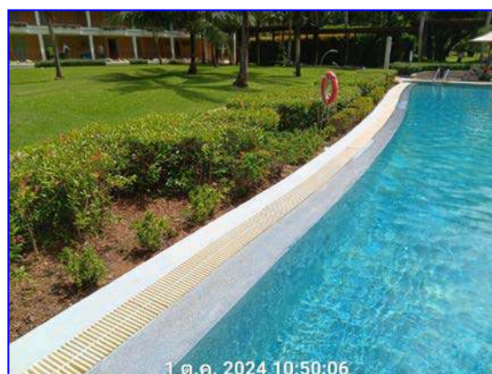
รูปที่ 2.32 รางระบายน้ำล้นมีฝาปิดรอบสระว่ายน้ำ
