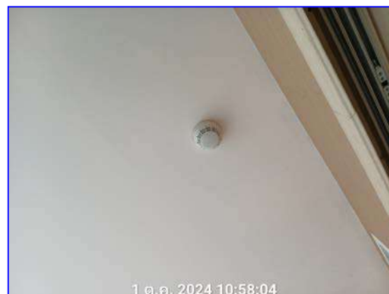
รูปที่ 2.50 ระบบตรวจจับควัน (Smoke detector)
